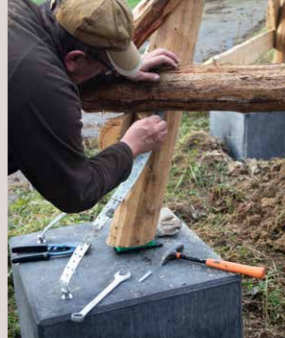
4 600-kg-Fundamente bilden die Basis, auf der das Gestell aus massiver Lärche fixiert wird. 2 Kunststoffunterlagen verhindern einen direkten Kontakt von Holz zu Unterlage und somit lebensverkürzenden Nässekontakt.
