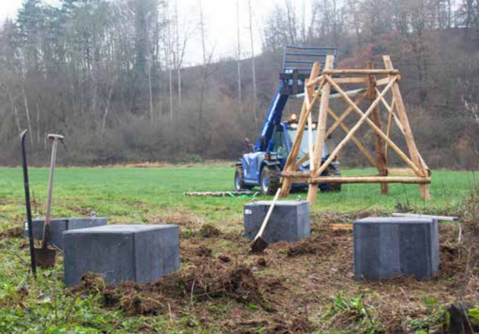
4 600-kg-Fundamente bilden die Basis, auf der das Gestell aus massiver Lärche fixiert wird. 2 Kunststoffunterlagen verhindern einen direkten Kontakt von Holz zu Unterlage und somit lebensverkürzenden Nässekontakt.
