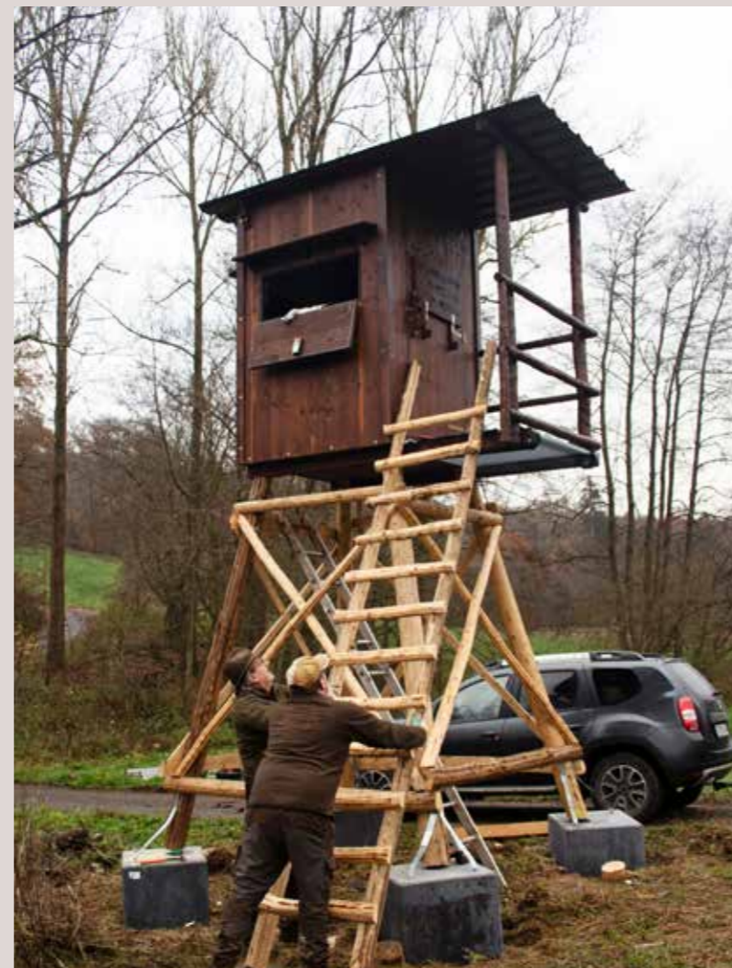
Die per Spezialvorrichtung am Ausleger befestigte Kanzel wird maßgenau auf den dafür vorbereiteten Unterbau aufgesetzt (l.) und arretiert. Schließlich wird die Leiter angepasst, fixiert sowie die Stirnseiten der Holme wetterdicht verkleidet (r.).
