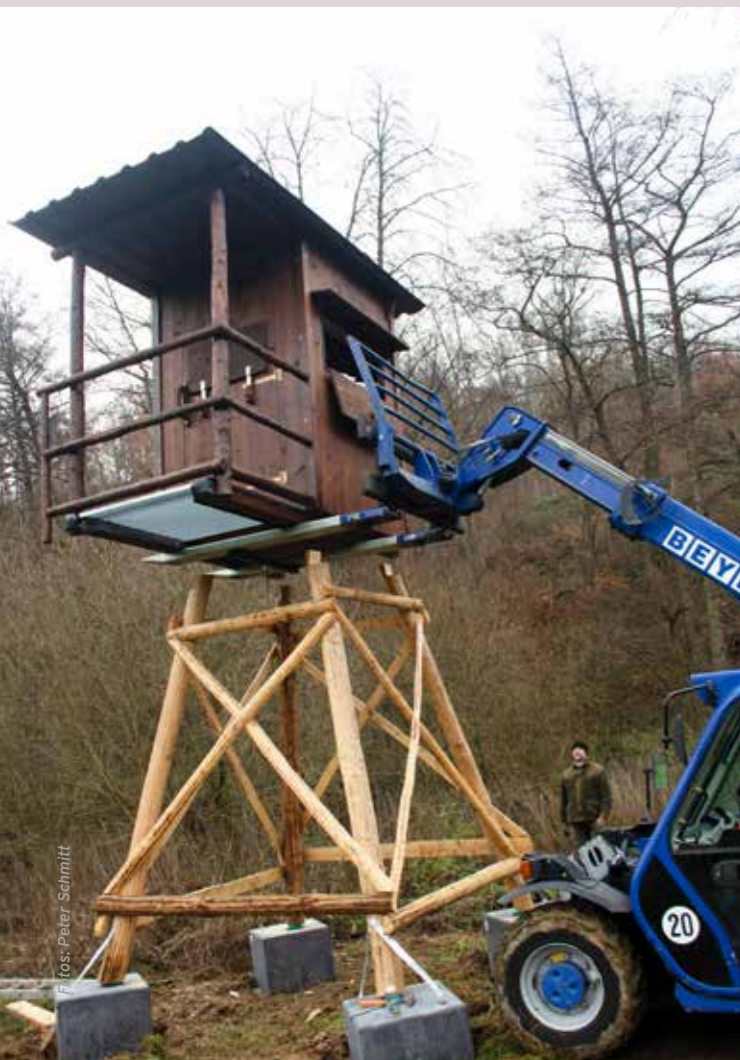
Die per Spezialvorrichtung am Ausleger befestigte Kanzel wird maßgenau auf den dafür vorbereiteten Unterbau aufgesetzt (l.) und arretiert. Schließlich wird die Leiter angepasst, fixiert sowie die Stirnseiten der Holme wetterdicht verkleidet (r.).
